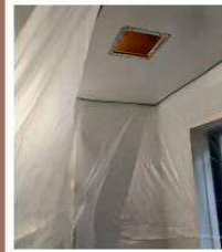
換気扇の取外しは、 浴室点検口から実施します。 その後、浴室暖房乾燥機の 取付寸法で大きく開口します。
