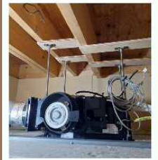
天井から吊り下げ設置となるため、 取付位置へ金物を取付け、本体を設 置します。
